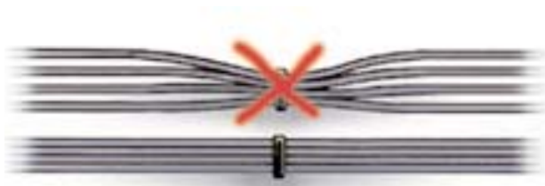
Fig. 5: Bunting av installert kabel
